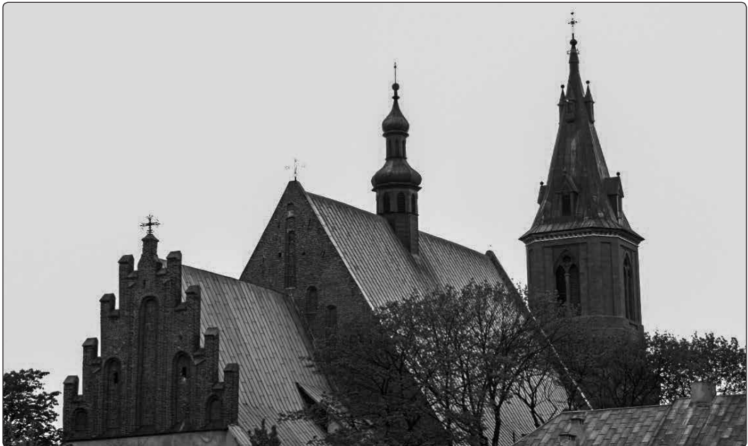
Il. 1. Dach Bazyliki św. Andrzeja w Olkusz, zgodnie z historycznymi opisami budowli, do pożaru w 1584 r. pokryty był ołowianą blachą. Fot. Jarosław Medyński
