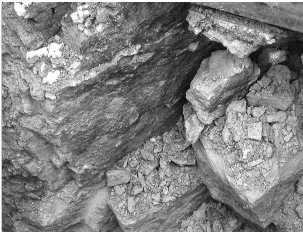
Il. 1. Tabl. 1. Bloki skały macierzystej przebijane podczas kładzenia rurociągu. Fot. D. Rozmus
