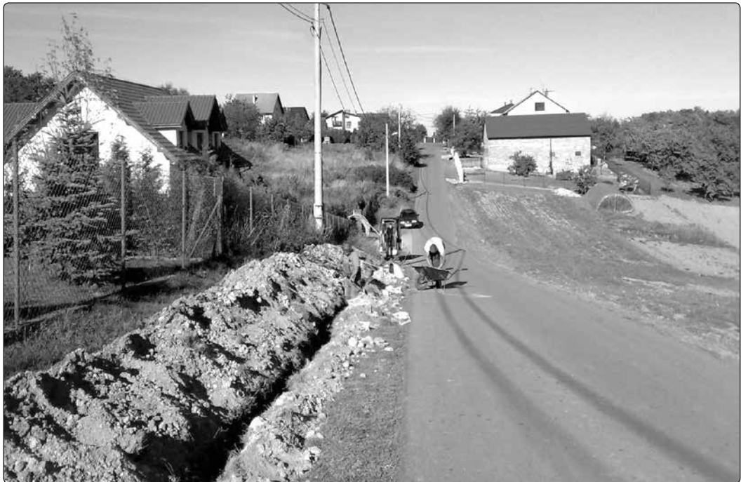
Il. 10. Bębło, wykop pod instalację gazowe, w którym można stwierdzić występowanie krzemianych zabytków. Fot. D. Rozmus
