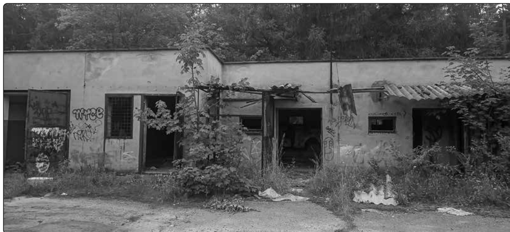
Il. 4. Ruiny budynków Spółdzielni Inwalidów „Laski” w Olkuszu (stan obecny). Fot. D.K.
