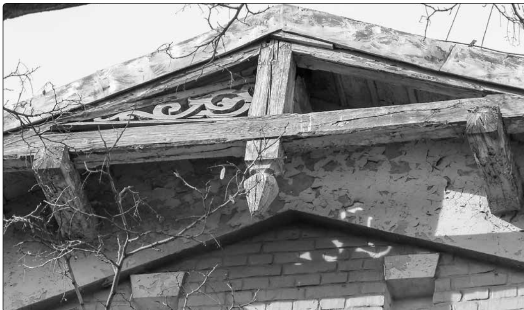
Il. 4. Drewniany element architektoniczny kalenicy, wspierający się również na drewnianych legarach, będący dopełnieniem szczytu dachu (widoczny od wschodniej strony elewacji budynku stacyjnego). Fot. D. Konieczny
