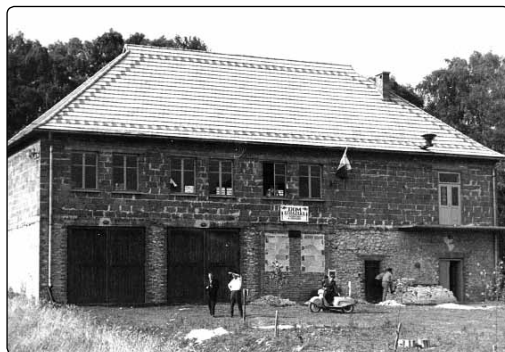
Budowa Remizy OSP w Gorenicach
