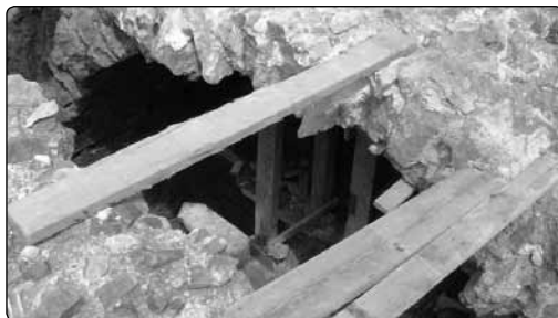
Częściowo zachowane sklepienie nad jedną z ratuszowych piwnic. Fot. D. Konieczny
