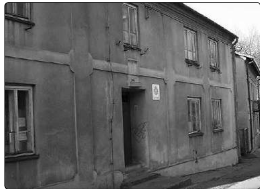
Budynek w Sławkowie (ryc. 1)
