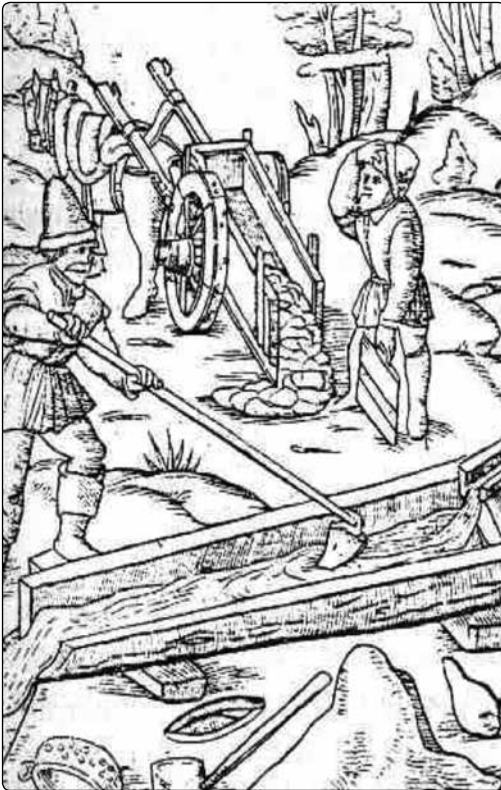
Rycina z dzieła Agricoli De re metallica z 1556 roku, przedstawiająca płukanie galeny w rymnie analogicznej do odkrytej w Hutkach. (ryc. 6)
