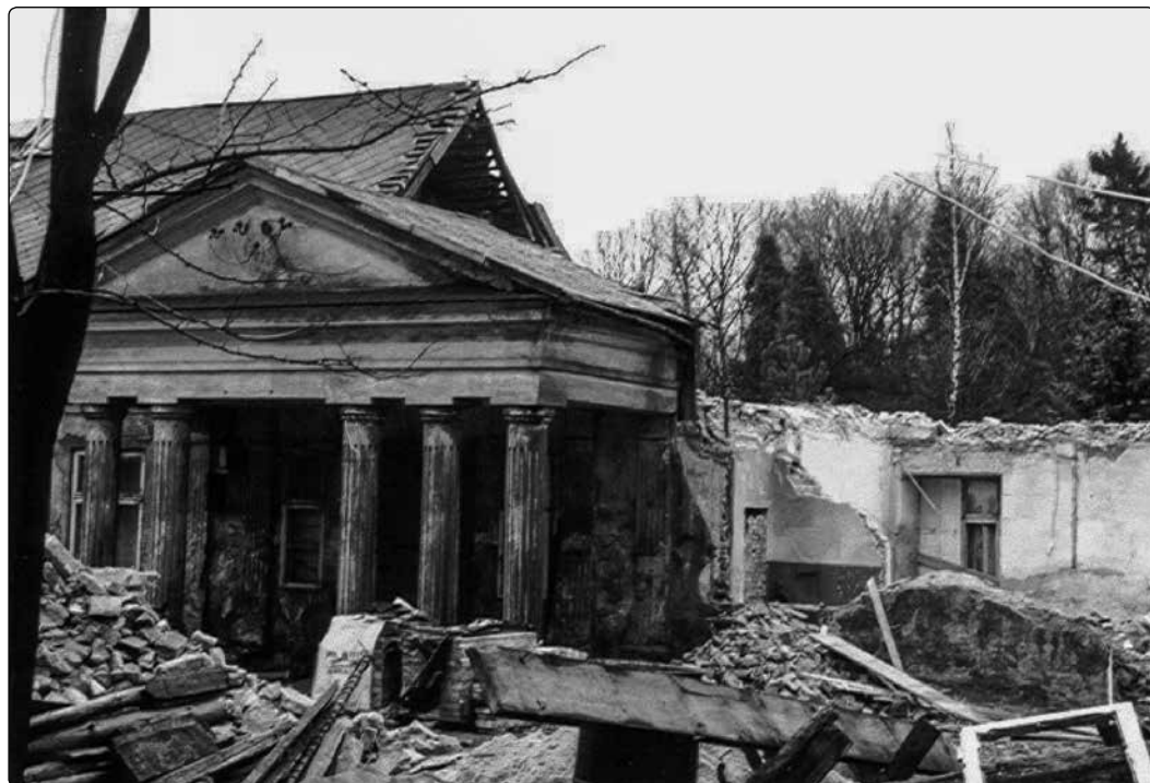
Il. 21. Dwór w Bolesławiu w trakcie remontu (fot. T. Sawicki)
