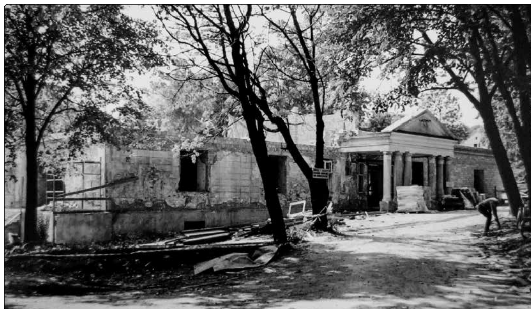
Il. 22. Dwór w Bolesławiu w trakcie remontu (fot. T. Sawicki)
