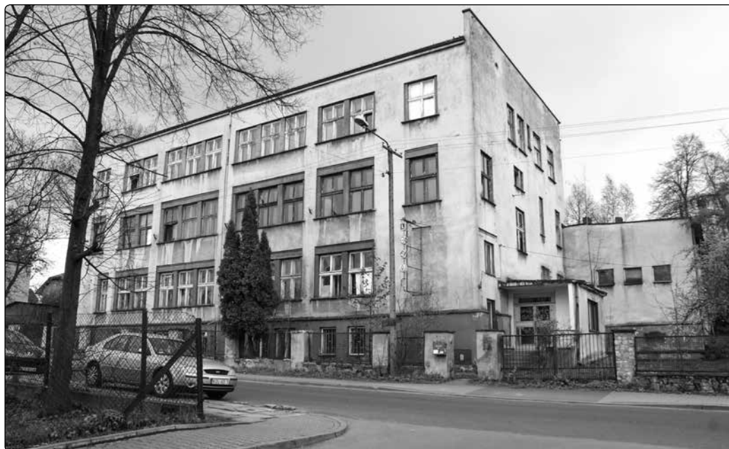
Il. 18. Budynek na Czarnej Górze, widok od południa - stan obecny (fot. M.P)
