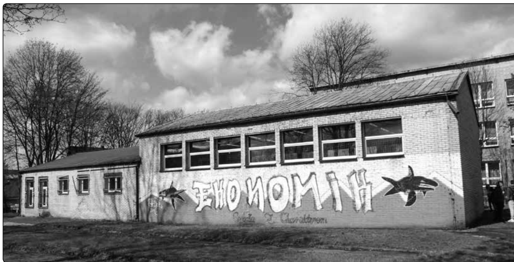
Il. 13. Sala gimnastyczna, widok od wschodu - wygląd obecny (fot. M.P.)
