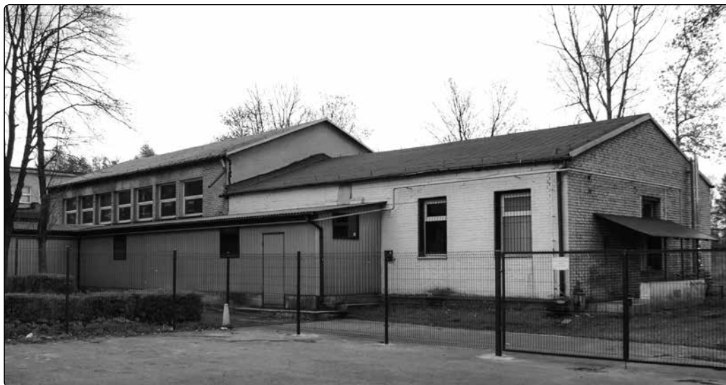
Il. 12. Sala gimnastyczna, widok od zachodu - wygląd obecny (fot. M.P.)
