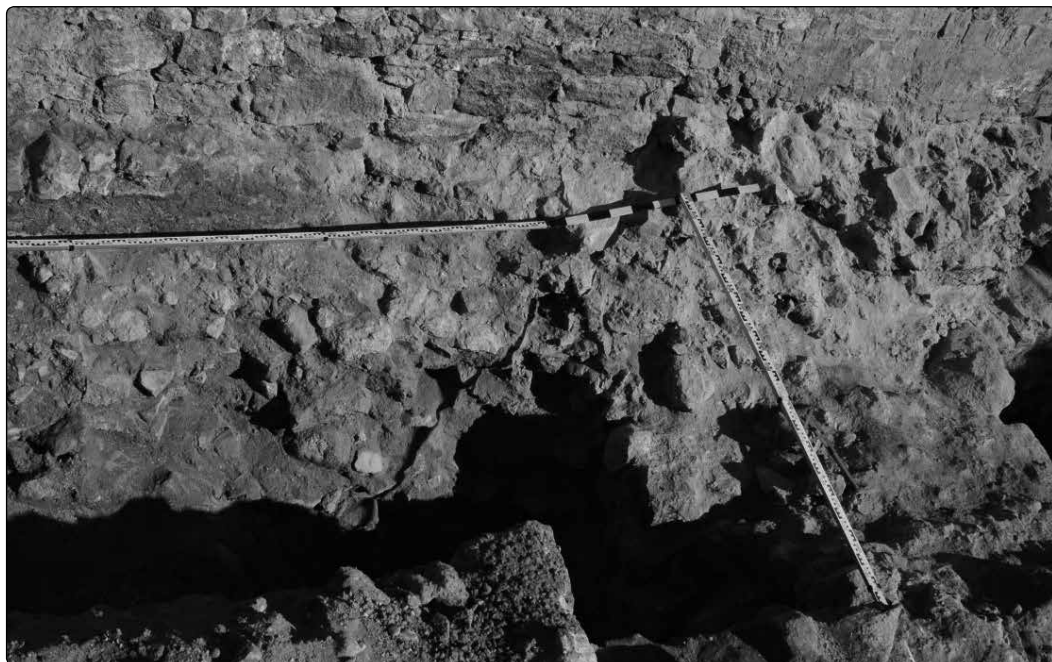
Il. 5. Wnętrze półbaszty. Widoczny brak licowania ciosami czerwonego piaskowca. Fot. D. Rozmus
