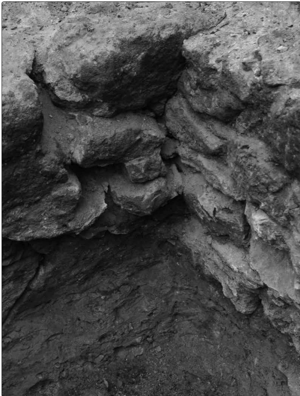
Il. 2. Przewiązanie muru obronnego z półbasztą. Świadczy to tym samym czasie powstania muru i półbaszty. Fot. D. Rozmus
