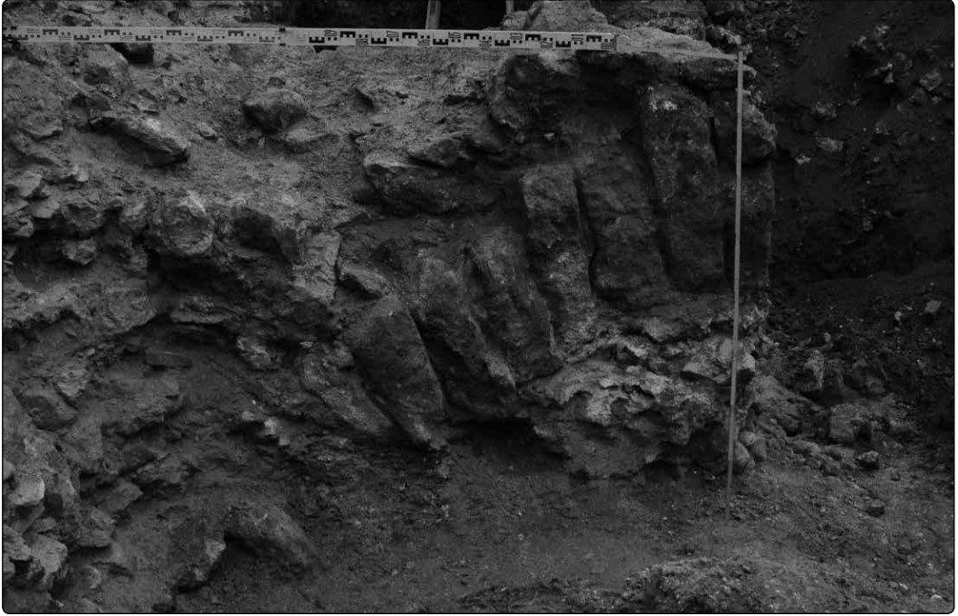
Il. 3. Wnętrze półbaszty. Ściana wschodnia - widoczne elementy łuku konstrukcyjnego. Fot. D. Rozmus
