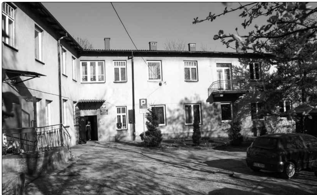
Il. 20. Budynek byłego internatu przy ulicy Gęsiej, widok od zachodu- stan obecny (fot. M.P.)
