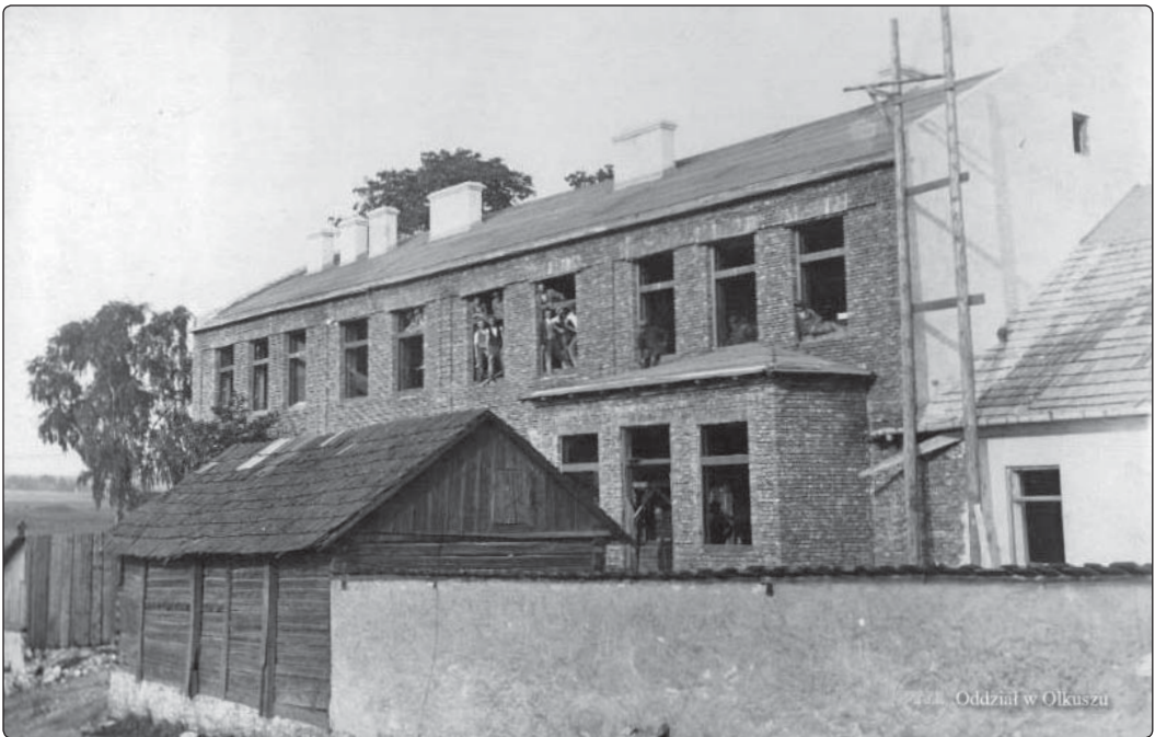
Il. 12. Budowa Szkoły Powszechnej przy ulicy Szkolnej (późniejsza Szkoła Podstawowa nr 2). 1939, Fot. arch. Muzeum Regionalne PTTK w Olkuszu, sygn.. PL_1047_001_003_0145, źródło: https://osa.archiwa.org
